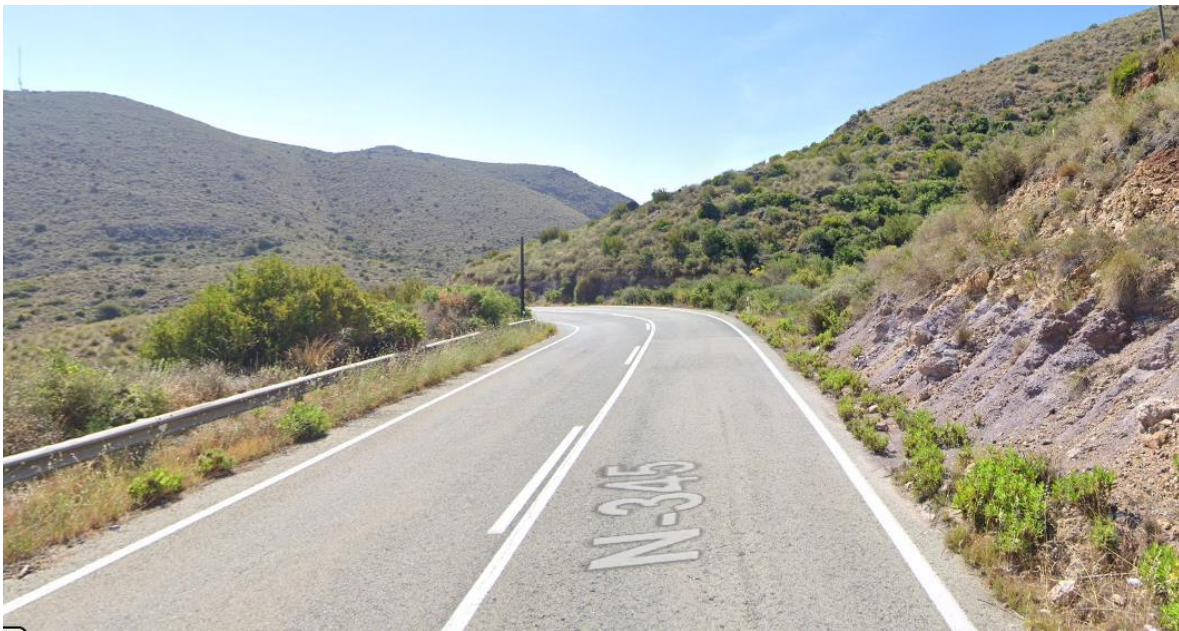
Tramo de Riesgo Alto en la carretera N-345 Murcia
