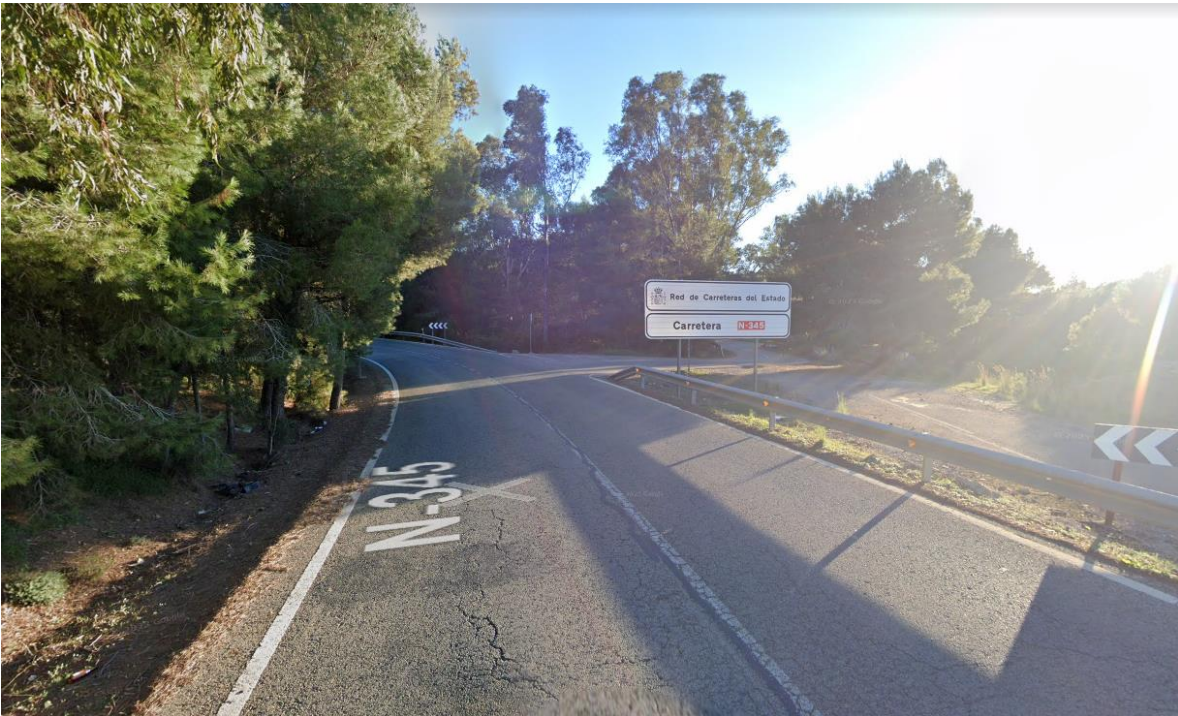
Tramo de Riesgo Alto en la carretera N-345 Murcia
