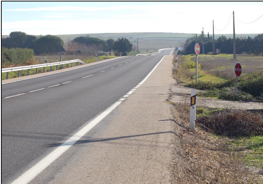
Tramo de Riesgo Alto en la carretera N-320
