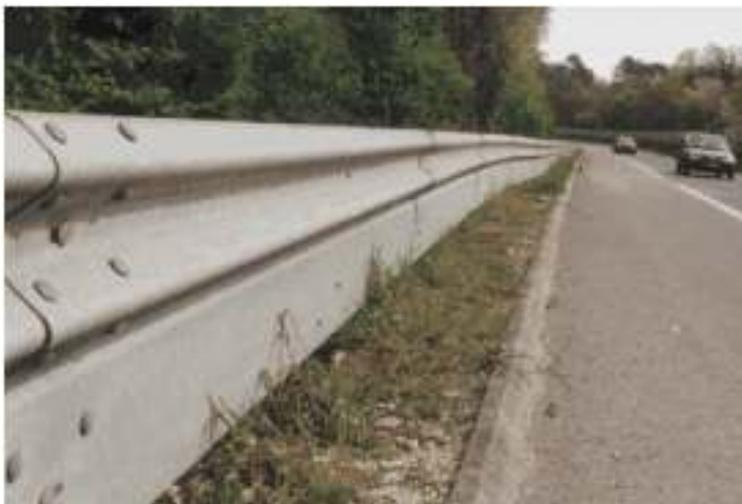
definen la bondad del dispositivo con los motociclistas, el sistema SPM ha sido ensayado a escala real mediante impacto de vehículo, garantizando que la protección de los motociclistas no reduce la eficacia de la barrera metálica
